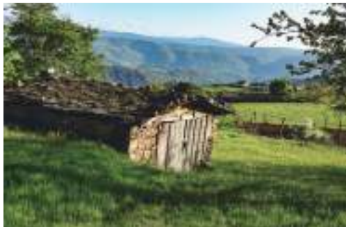
Construción tradicional na Lampaza.
