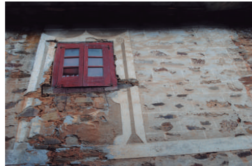
Detalle esgrafiado en una ventana en Montefurado.
