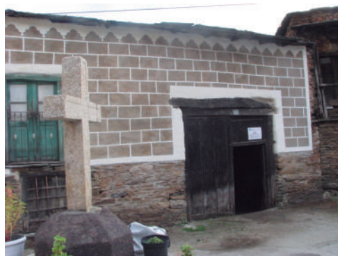
Fachada Norte de la “casa do Carteiro” restaurada en 2017.
