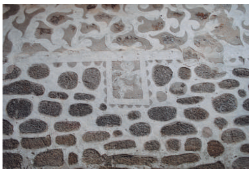
Encintado esgrafiado en la parte inferior y esgrafiado con textura en la superior.
