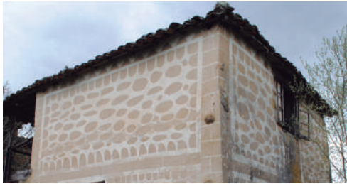
Encalado/pintado sobre revestimiento liso en fresco y sin marcado por incisión.
