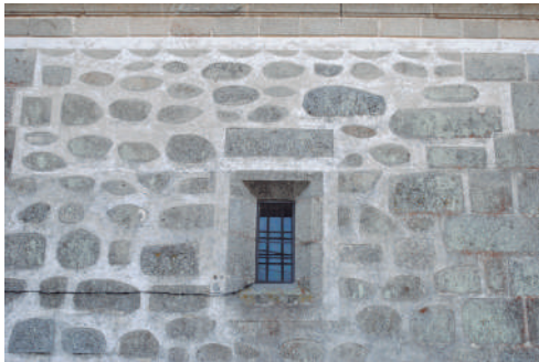
Combinación de encintado y esgrafiado.
