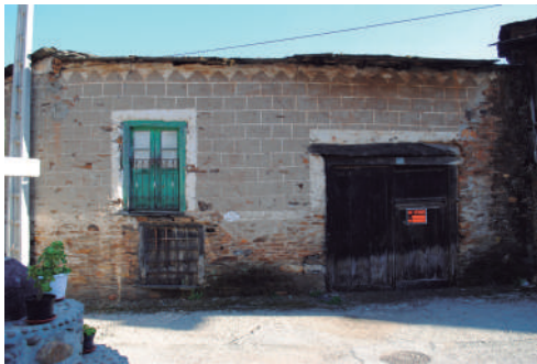
Fachada Norte de la “casa do Carteiro” antes de la intervención.
