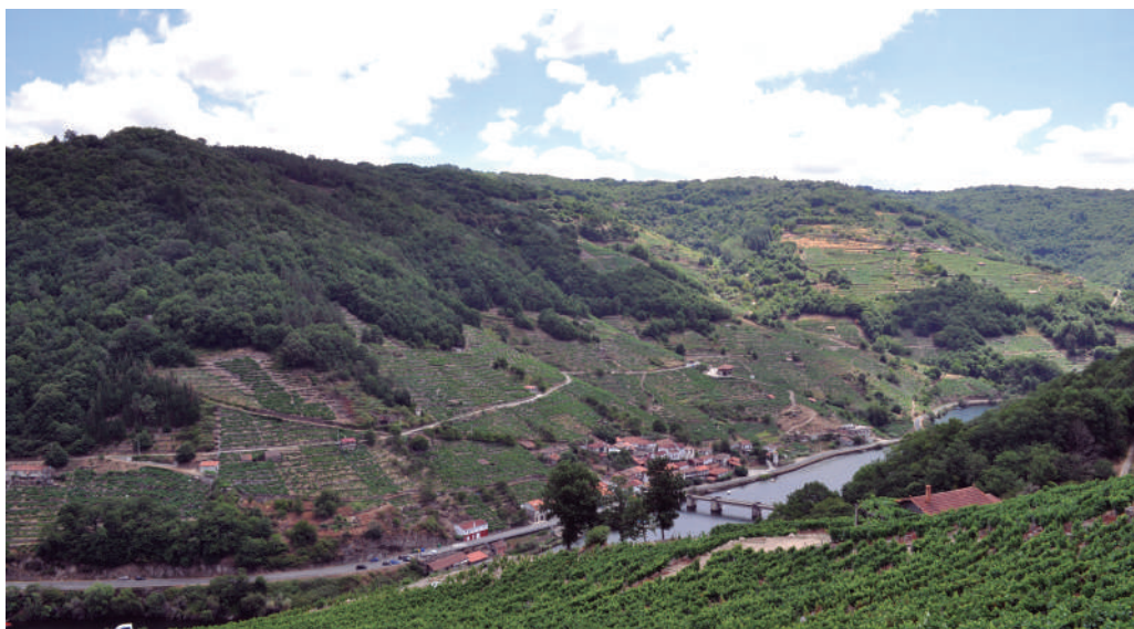
Puente de Belesar sobre el río Miño
