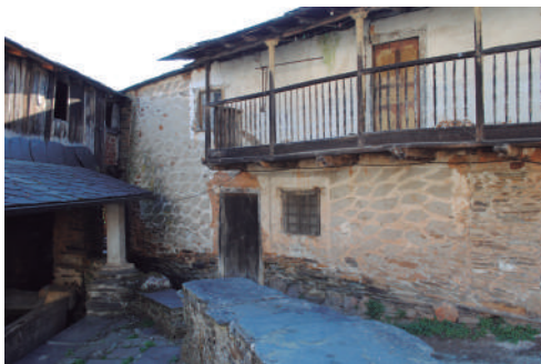
Fachada Este de la “casa do Carteiro” antes de la intervención.
