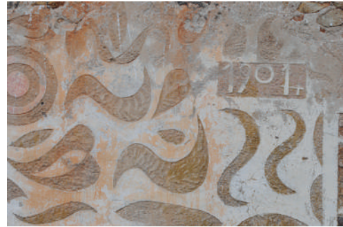
Esgrafiado, revestimiento continuo sobre el que se han recortado las formas.
