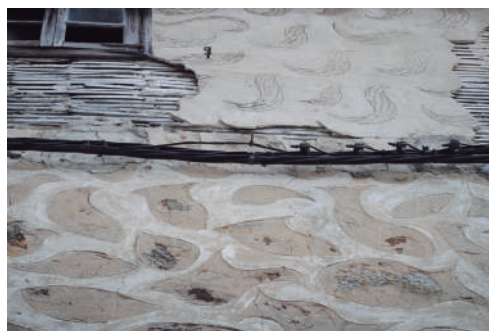
Decoración sobre el pallabarro (entramado, barrotillo...)
