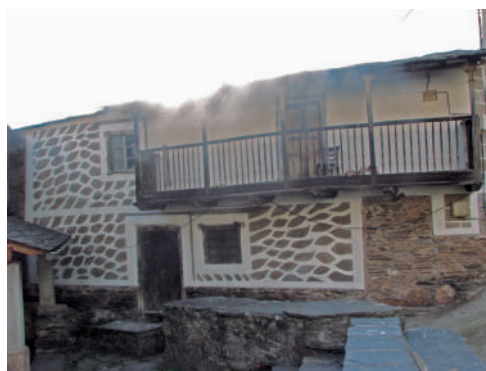
Fachada Este de la “casa do Carteiro” restaurada en 2017.
