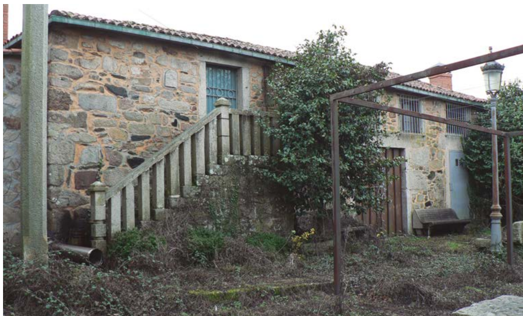
A Casa da Meiriña aproveitou os materiais da derruída torre de Lalín.
